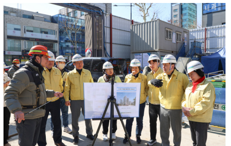
조사특위 2반 현장조사 도선동 286 역세권 청년주택 공사현장
